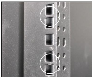
3. 从机架内，将滑轨后端固定勾放置在在这下方薄型间隔的后方安装孔，然后将滑轨前端固定勾放置在下方薄型间隔的前方安装孔，如右图所示。
